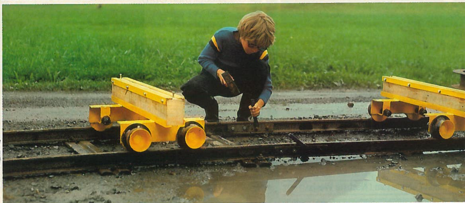
Unten: Bau der kürzesten Eisenbahnlinie der Schweiz FOTO: M. WILLI
